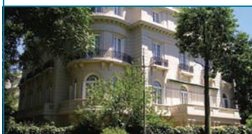
MARISCAL CASTILLA 2720 1914/1921 ARQ. CARLOS NORDMAN. ARQ. ARANDA (R)
