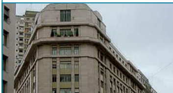
33> EX EDIFICIO CHADE - VOLTA
